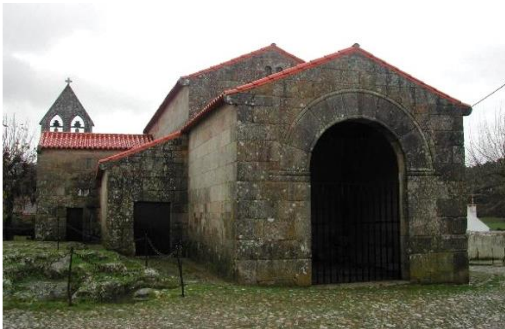
Fig. 2 - Igreja de São Pedro de Lourosa - Vista geral (fachada principal)
